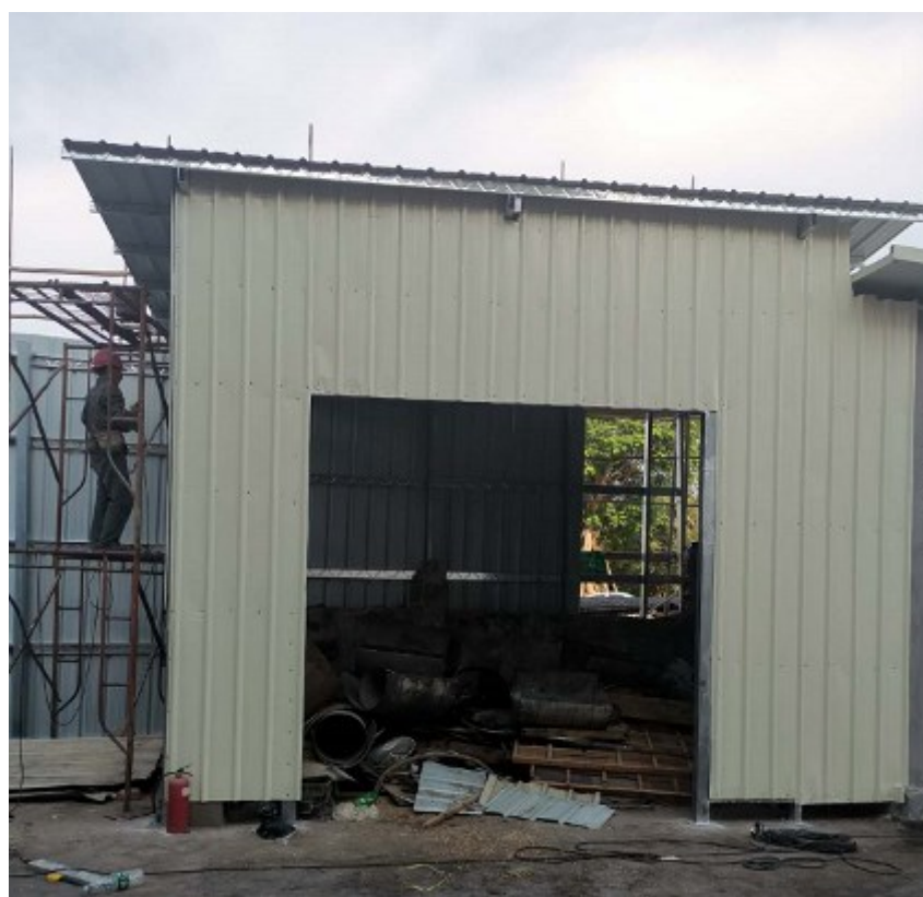
一般固废堆放区域
