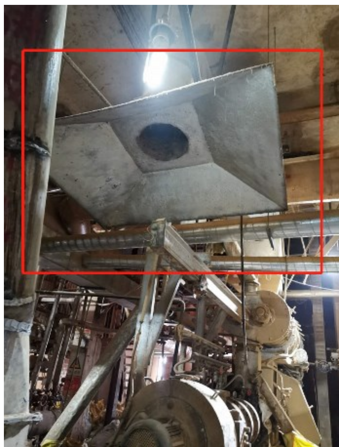
恶臭污染物集气罩收集方式
